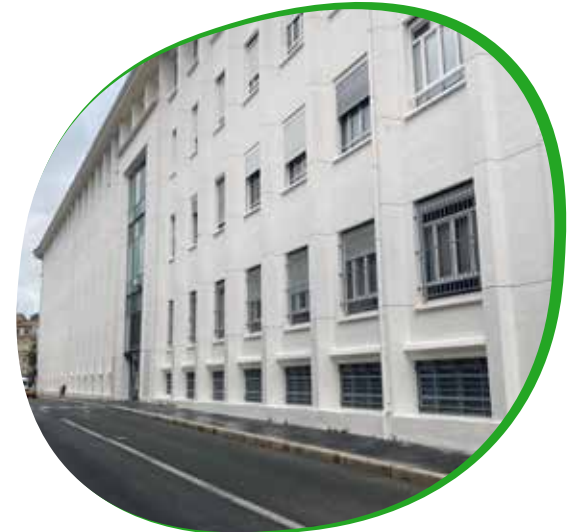
Rénovation de façade
